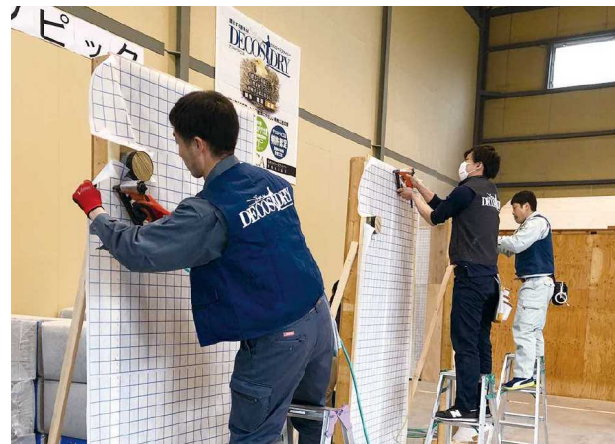
仮設のバネに吹込み施工を行い、速さ・正確性(充填性、密度)を誇りブローイングピックのようす。
