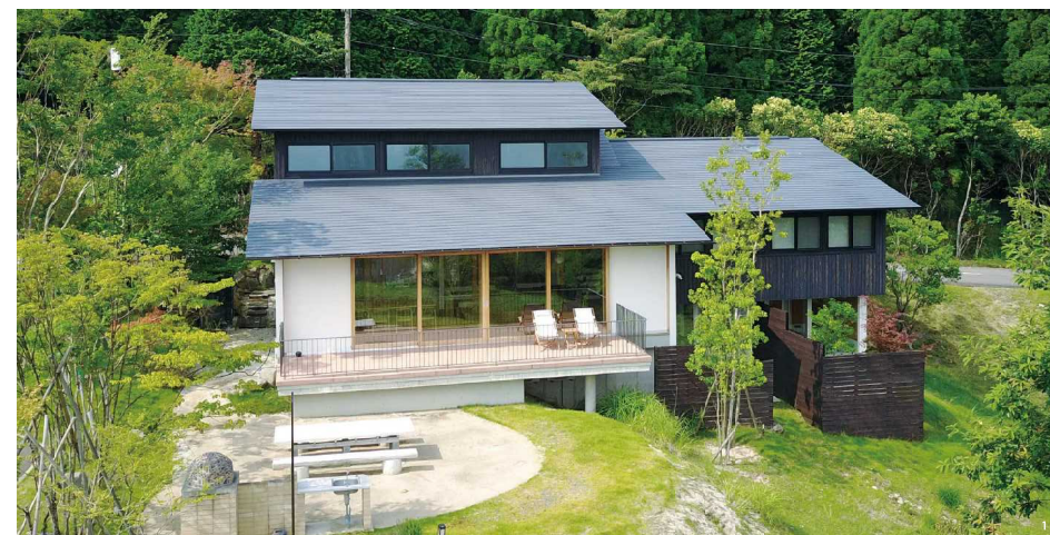
1/湯布院ゲストハウス「風陽館」LDKから九重連山を一望することができます。2/宿泊体感施設「やすらぎ館」外観。3/内観、リビングダイニング、OMX、ベレットストーブ、オリジナルアイランドキッチンを使い勝手を確認してください。
