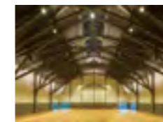
写真／「蛭遊苑」の大ホールと企業展示ルームは、杉材の変形トラスの架構をもった空間となっている。当初図面を見たときは、この複雑な架構をどう組み立てるのか？と相当不安になったものだ。問題は2つ。一つは品質の安定した乾燥した構造材が確保できるか？である。これについては大分県上津江村と取り組んでいる天然乾燥「輪掛け乾燥材」があるため、ほぼクリアできると考えていた。実際、上津江村のストックヤードに設計士の泉さんをお連れし、しっかり材料の吟味を頂き、その質、量にお褒めの言葉をいただいた。次にコンピュータでしか解析できない複雑な梁・桁架構の機械加工である。超高度なプレカット加工に実績のある山佐木材㈱[鹿児島県]をお願いすることで解決を見た。(安成)
